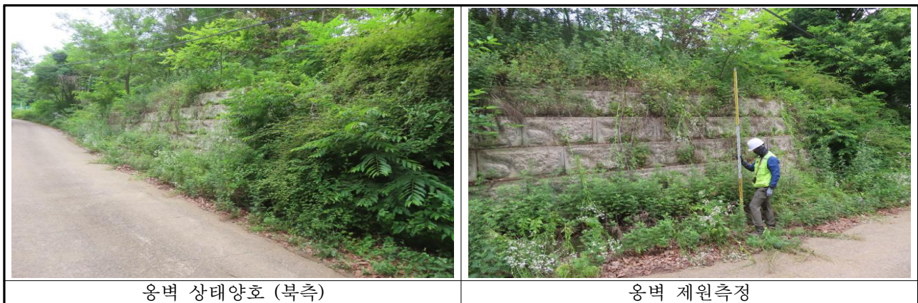
【사진 3.8】 기타 부대시설 손상사진
